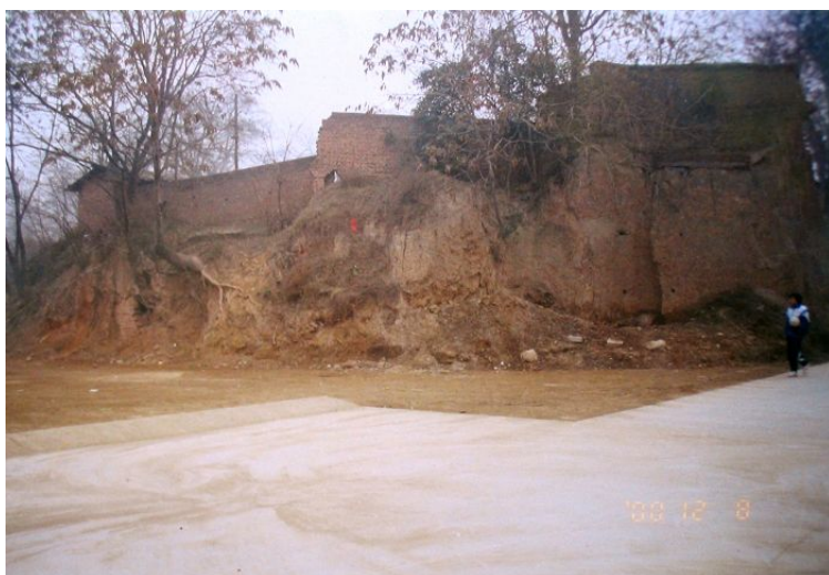
胭脂坡中心西端遗迹(2000.12.8 摄影)
